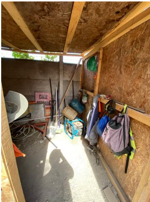
Fotografía N°7: No se encuentran extintores en los lugares de trabajo en proyecto "Reposición de Veredas Población René Schneider".
