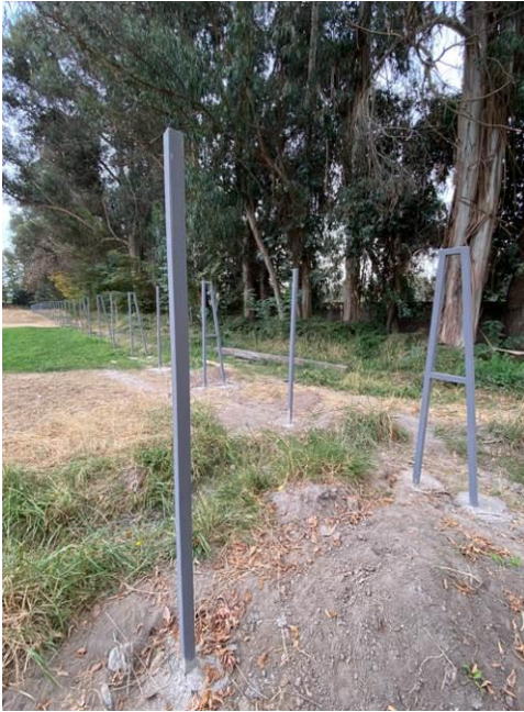
Fotografía N°21: Instalación de perfiles cuadrados en cierre cancha del contrato "Mejoramiento y Construcción Estadio Municipal de Tinguiririca".
