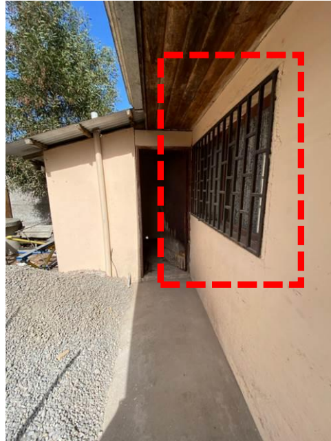
Fotografía N°2: Falta protección ingreso de vectores en el contrato "Reposición de Veredas Población René Schneider".
