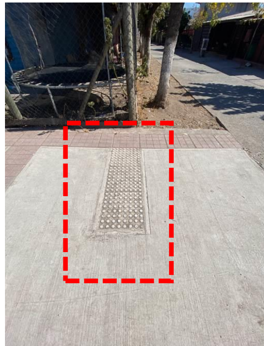
Fotografía N°12: Las rampas antideslizantes no son anteceditas completamente por un pavimento podotáctil en contrato "Reposición de veredas en Calle Javiera Carrera Hasta Rosendo Jaramillo".
