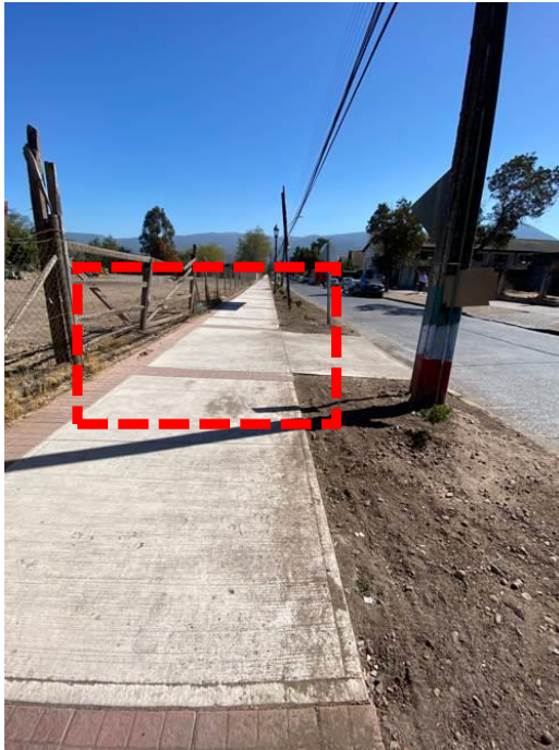
Fotografía N°13: Las rampas antideslizantes no son antecedidas por un pavimento podotáctil en contrato "Reposición de veredas calle García y Reyes".
