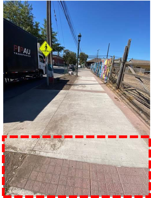
Fotografía N°14: Las rampas antideslizantes no son antecedidas por un pavimento podotáctil en contrato "Reposición de veredas calle García y Reyes".
