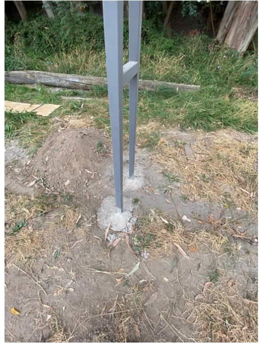
Fotografía N°22: Instalación de perfiles cuadrados en cierre cancha del contrato "Mejoramiento y Construcción Estadio Municipal de Tinguiririca".
