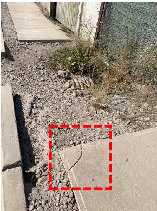
Fotografía N°13: Las rampas antideslizantes no son antecedidas por un pavimento podotáctil en contrato "Reposición de veredas calle García y Reyes".
